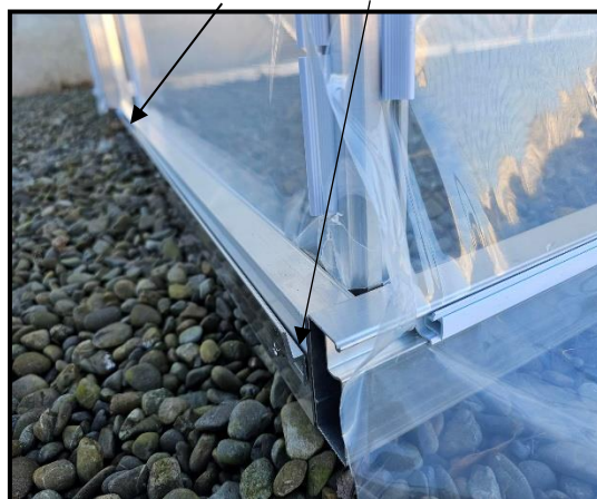
Pic D2 Door guide fin underside of door, and door fin guide slot
