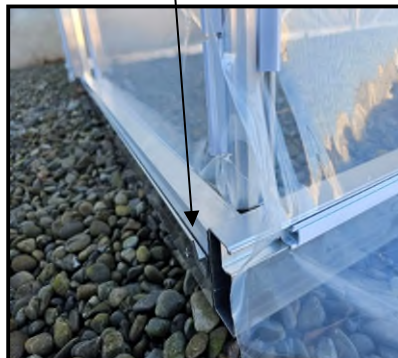
Pic D2 Door guide fin underside of door and door fin guide slot
